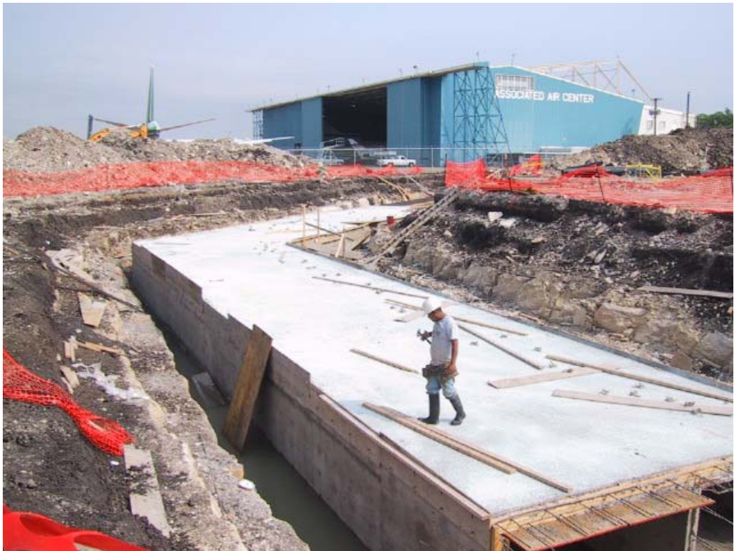
Culvert top poured
